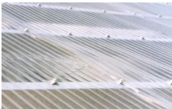
写真：波打ちした施工例
