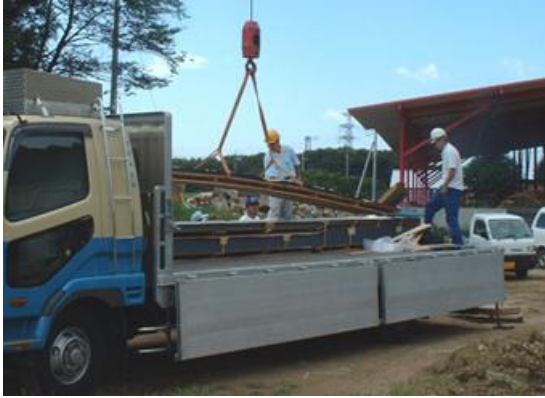
① トラックからの積みおろし
