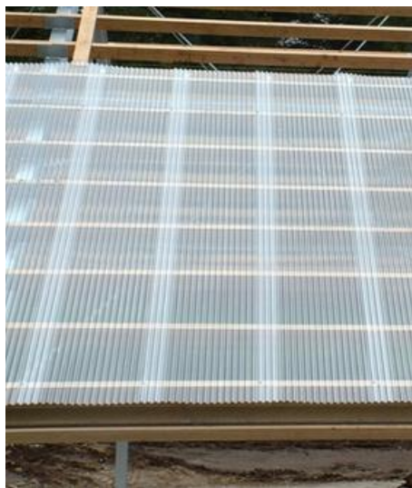
写真：重ね代 3.5 山での施工例
