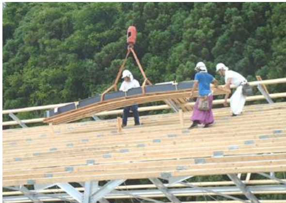
③ クレーンで施工面へ移動
